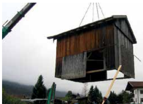
Wir haben Städel versetzt und Brücken gebaut
